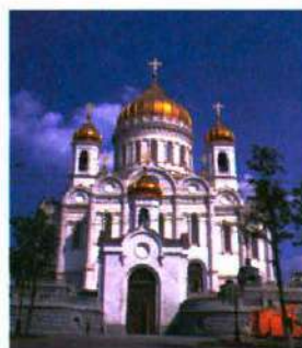
Храм Христа Спасителя в Москве. Архитектор К. А. Тон (реконструкция)
